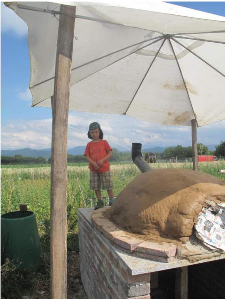
Normalerweise lässt man an dieser Stelle alles gut ein paar Tage trocknen. Da hier jedoch alles an einem Tag gebaut werden soll, werden Steine um den Rand gelegt und mit Draht am Platz gehalten, um ein auseinander drücken zu vermeiden. Denn nun wird ein Sandhügel errichtet. Dieser stellt später den Ofeninnenraum dar und wird nach dem Errichten der Seitenwände und dem Trocknen dieser entfernt. Wichtig hierbei ist den Hügel groß genug und fest genug zu errichten.
