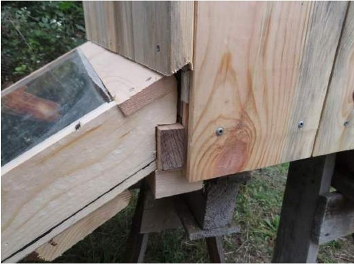
Das Kniffligste ist der Anschluss zwischen Trockenschrank und Sonnenkollektor.
