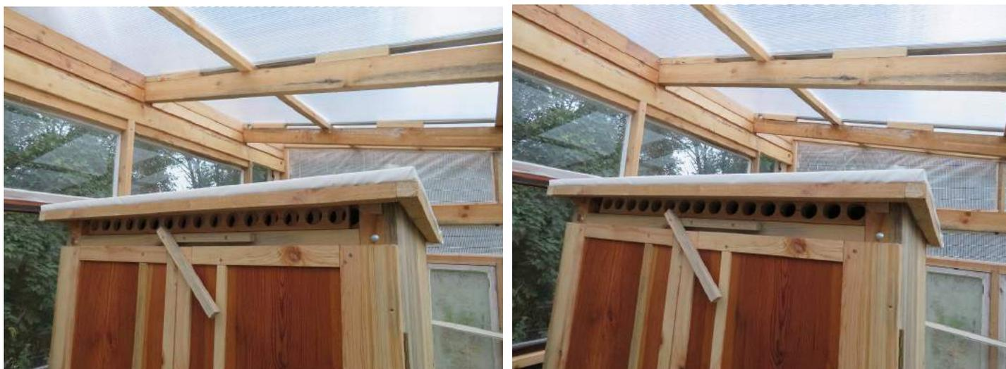
Über den Türen ist ein Abluftsystem eingebaut. Es soll die Regulation der Wärme im Dörrer ermöglichen. Je nach Wärme kann die Luft dann schnell oder langsam entweichen und verbleibt so länger im Kasten.
