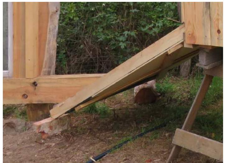
Nach unten hin sind die Rahmenseiten etwas länger, sodass die Platte etwas vom Boden entfernt bleibt.
