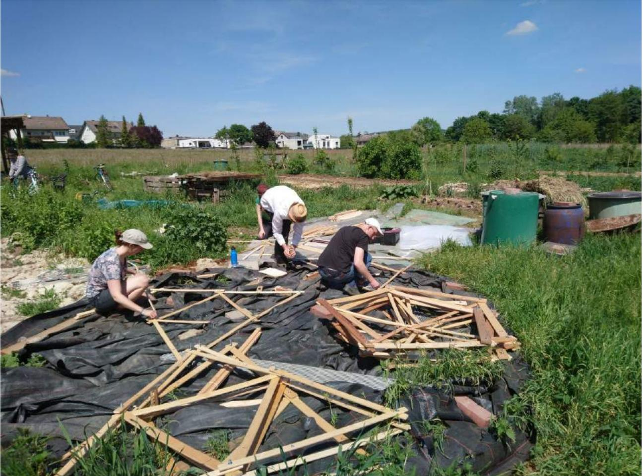
Wir haben die jeweiligen Latten genommen und sie dann mit den Gewindeschrauben verbunden. Anschließend haben wir an ein Fünfeck 5 Dreiecke gebastelt und die Latten B und D, dann sah die Konstruktion so aus:
