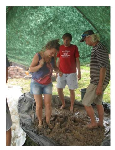
Der fertig gemischte Lehm erinnert dabei stark an einen gut gekneteten Brotteig. Er klebt nicht mehr an der Schüssel bzw. hier an der Unterlage und hält die Form. Formt man eine Kugel und lässt sie auf eine Flache Unterlage fallen, sollte die Kugel wie ein halbes Brötchen aussehen. Erinnert sie dagegen an einen Fladen, ist zu viel Wasser enthalten. Zeigt sie Risse, ist nicht genug Wasser vorhanden.
