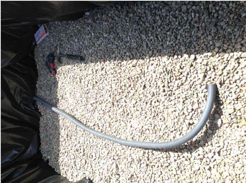
5. Seitlich ins Beet einen Loch für den Ablaufschlauch bohren. Der Schlauch sollte stabil aufliegen, damit er später nicht abknickt, wenn der Kies absinkt. Eventuell also das Schlauchende mit größeren Steinen stabilisieren.
