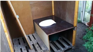
An der Rückwand wurde eine Klappe eingebaut um die Auffangbehälter leeren zu können:
