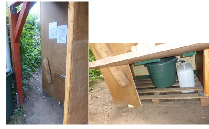
Für Wände und Pfosten wurden im wesentlichen große Holzplatten sowie insgesamt fünf Pfosten aus dem Baumarkt (nach einer Lasur) aneinander geschraubt. Als Auffangbehälter dienen ein 20L Kanister (dieser war nach dem Sommerfest voll), sowie ein großer Plastikeimer. Wichtig ist, dass der Kasten in dem die Auffangbehälter verstaut sind relativ Luftdicht gebaut wird, damit nicht so einfach Fliegen zu den Fäkalien und wieder zurück gelangen
