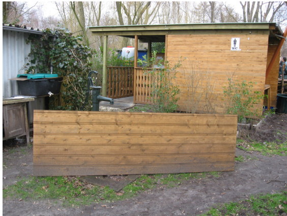
Seitenansicht mit der herausgenommenen unteren Rückwand im Vordergrund
