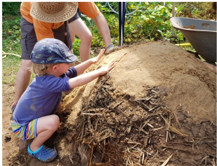
1: Foto: J. Klinkhammer: Mit Sand wird der grob vorgefertigte Innenraum geformt
