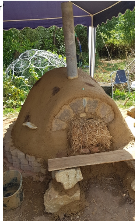
2: Foto: J.Klinkhammer: der Ofen, bereit für die mehrwöchige Trockenphase
