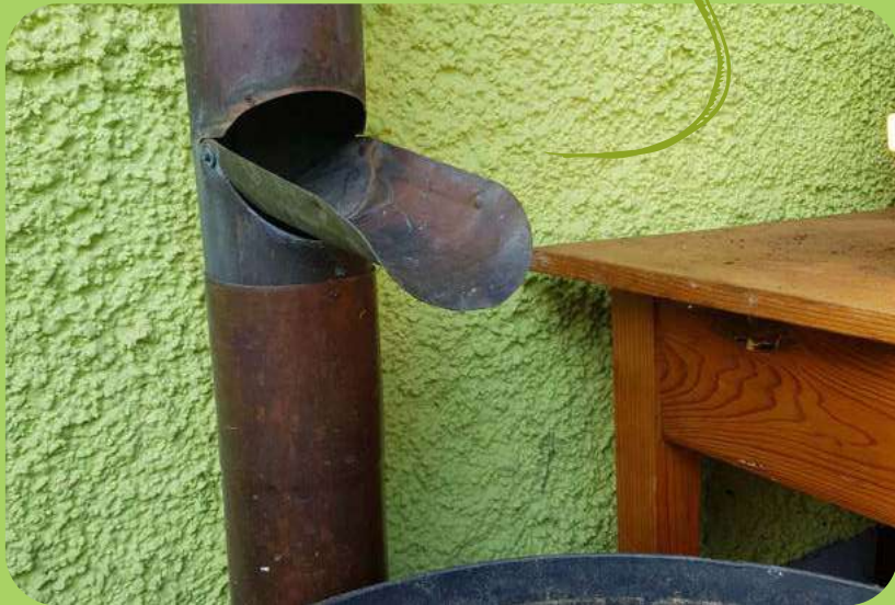
2 | Einfacher Regensammler mit Klappe
